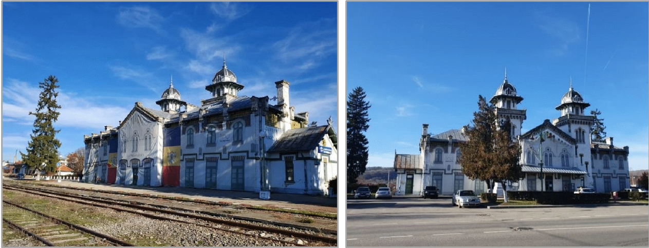
Figura 2.106. Stația Curtea de Argeș.
