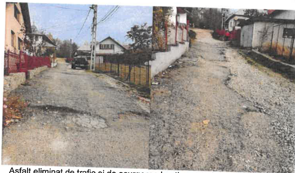
Asfalt eliminat de trafic si de scurgerea haotica a apelor, declivitate mare
