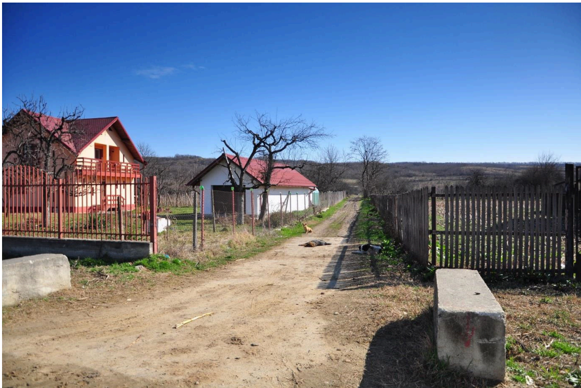
Imaginea 1 | Stradă neasfaltată, subdimensionată, fără semnalizări rutiere la intersecția cu strada de categoria II - sat Boțârcani - intersecție cu DJ 702
