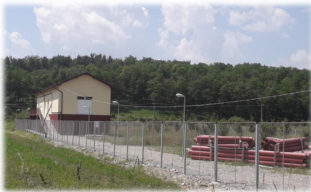
Foto nr. 8 – Stația de epurare Orașul Minier
